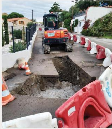
Creusement d'un pluvial aux Tamarins.
