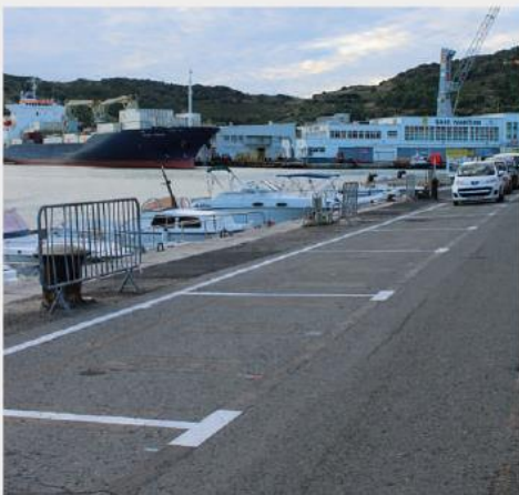
Enlèvement des filets de pêche et création d'un couloir piéton et d'aires de stationnement quai Jean Moulin.
