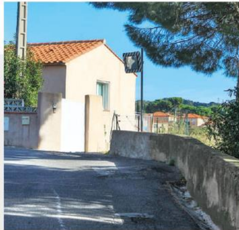
Eclairage, miroir de rue et traçage au sol de la Route Stratégique.
