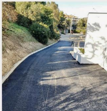
Travaux d'amélioration de l'accès au stade.
