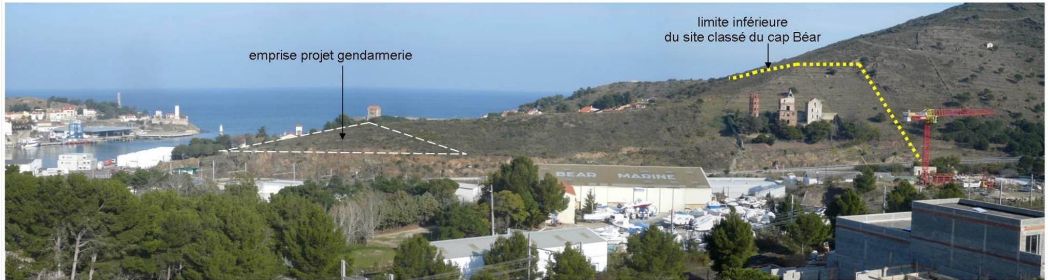
2 : Vue depuis le carrefour RD914 / RD86b, desserte du port
