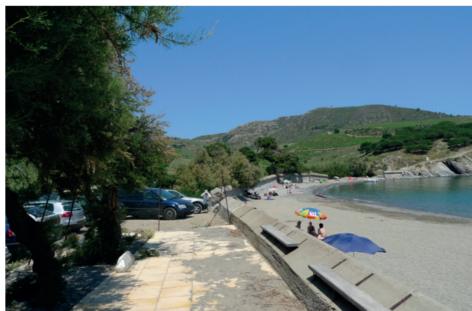
L'immédiate arrière plage aménagée contre le mur anti débarquement
